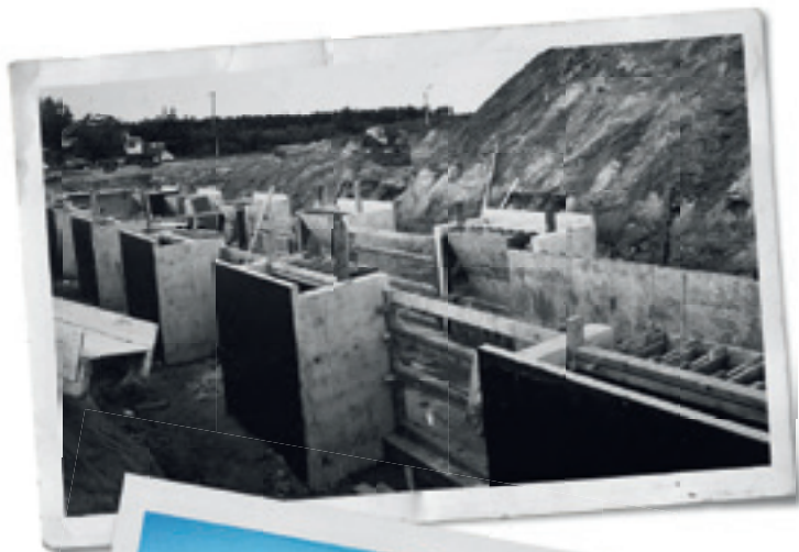
Speciale brugfundering om mijnverzakkingen te compenseren (1970).
