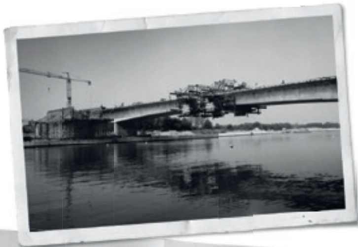
Bouw van de brug (1969).
