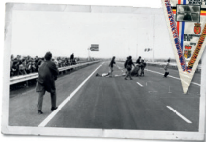
Protest bij de officiële opening van de brug over de Maas en het Julianakanaal. (© Stichting Erfgoed Eisden)
